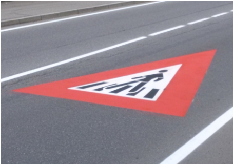
Segnaletica Orizzontale su pavimentazione bituminosa
